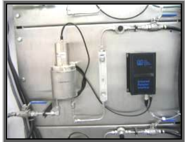
Figure 13 : Dispositifs de contrôle permanent des rejets d'effluents gazeux dans l'établissement Bêta Plus Pharma à Bruxelles
